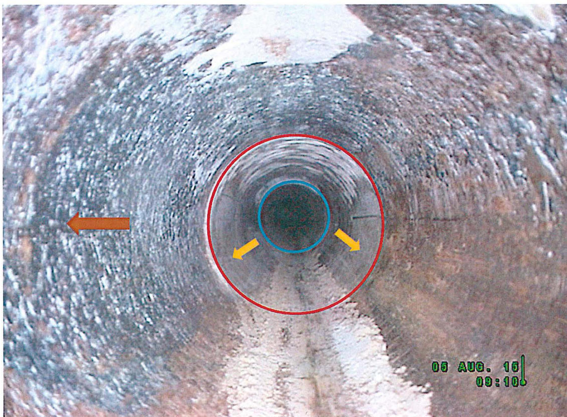
Abbildung 4: Position des Kamerakopfs bei 3,00 m, Übergang (roter Kreis) vom Standrohr (brauner Pfeil) zum Injektionsmörtel (orange Pfeile) bei 3,42 m, Übergang vom Injektionsmörtel zum Steinsalz (blauer Kreis) bei 4,04 m
